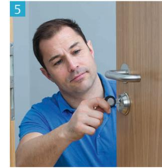
5 CLIQ® Go-Zylinder lassen sich einfach und ohne Verkabelung in der Tür installieren und sogar vor Ort auf verschiedene Türstärken anpassen.
